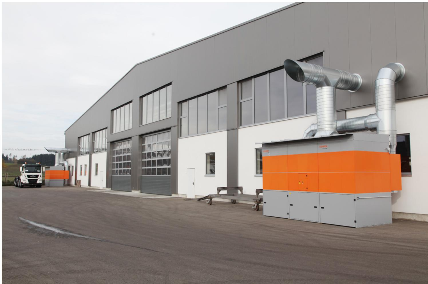
Entstehen in der Produktion große Schweißrauch- oder Schneidstaubmengen? Verfügt die Produktion über mehrere Arbeitsplätze? Dann sind zentrale Absauganlagen für Schweißrauch und Schneidstaub oft das Mittel der Wahl. Dank ihrer hohen Leistungsfähigkeit ermöglichen sie eine saubere Hallenluft. Bei der Investition in eine Anlage sollten Betriebe nicht nur auf die Ausstattungsmerkmale achten.
