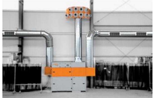
[Realisiert wird sie über zentrale Filteranlagen und angeschlossene Rohrleitungssysteme](#). Auch die meisten [Filtertürme](#) arbeiten nach diesem Prinzip. Zu den Mischlüftungssystemen, die bei unklarer oder geringer Thermik eingesetzt werden, zählen [die Anlagen mit Weitwurfdüsen](#) und auch die sogenannten [Push-Pull-Systeme](#). Sie erzeugen in der Halle einen horizontalen Luftstrom, der Verschmutzungen auf eine Saugrohrleitung zutreiben soll.
