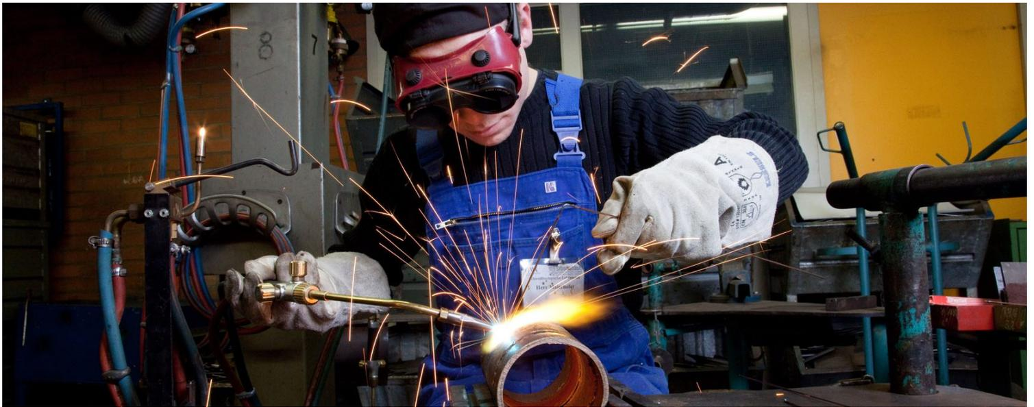
Nitrose Gase sind oft verantwortlich für akute Vergiftungen beim Schweißen. Sie entstehen bei Autogen- und Lichtbogenverfahren. Aufgrund aktueller arbeitsmedizinischer Erkenntnisse wurden die Arbeitsplatzgrenzwerte für nitrose Gase im Mai 2016 deutlich abgesenkt.
