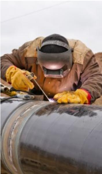
Das Heimtückische für die Gesundheit der Schweißer dabei: Umhüllte Stabelektroden entwickeln beim Abschmelzen Gase und Schweißschlacken. Die Gase aus der Umhüllung stabilisieren den Lichtbogen und schirmen das Schweißbad vor der Oxidation durch den Luftsauerstoff ab. Die Art der Gefährdung hängt von der Zusammensetzung der Hülle und des Kerndrahtes ab. Beim Lichtbogenhandschweißen unterscheidet man zwischen den vier Umhüllungsarten sauer, rutil, basisch und zelluloseumhüllt.
