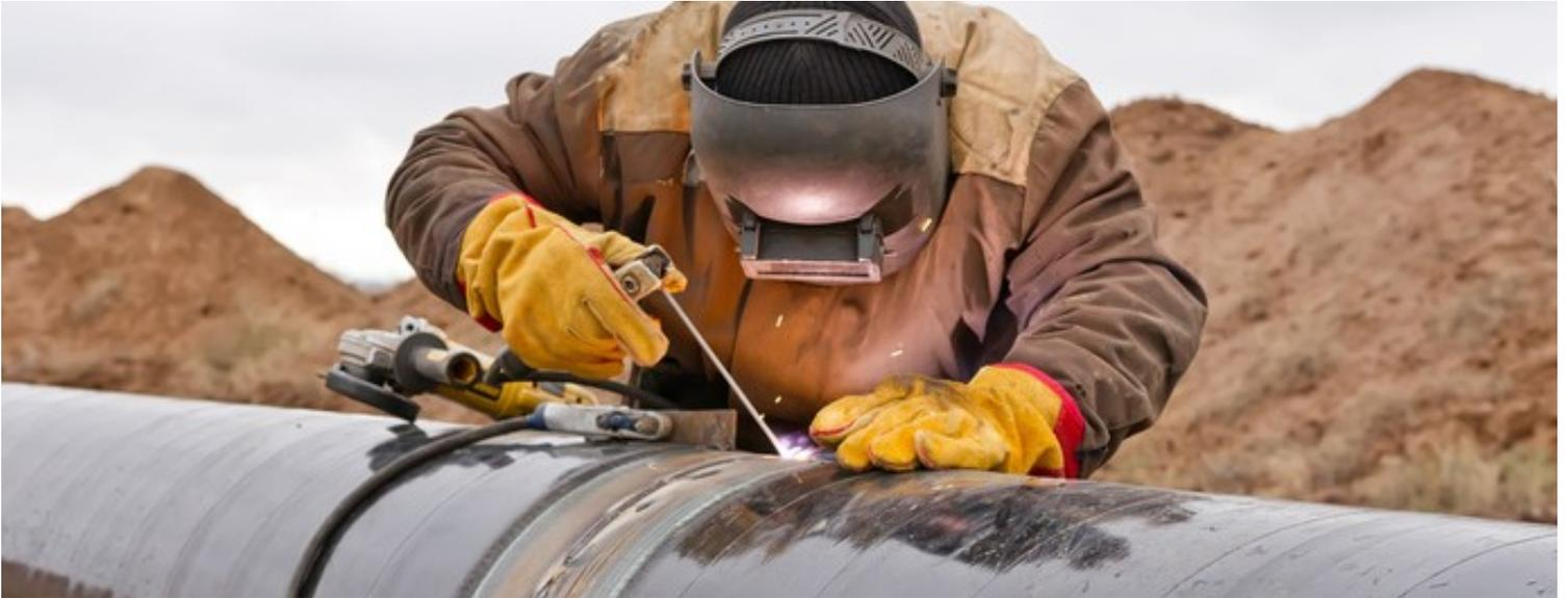
Bis hin zur Entstehung von Chrom-VI-Verbindungen: Beim Lichtbogenhandschweißen hängt die Art der Gefahrstoffe im Schweißrauch entscheidend vom Werkstoff des Kernstabes und seiner Umhüllung ab. Hochlegierte Stabelektroden sind besonders gefährlich.
