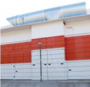
Zentrale Absaug- und Filteranlage in Wetterschutzausführung: Mit einem Luftvolumenstrom von 54.000 m<sup>3</sup> saugt die Anlage zur Luftreinhaltung an 36 Arbeitsplätzen den Schweißrauch ab.
