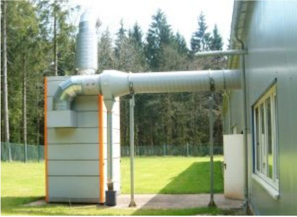
Ein integrierter Frequenzumrichter in der Absauganlage passt den Volumenstrom automatisch an die Bedürfnisse der Fertigung an. Unabhängig davon, ob nur an einem Arbeitsplatz oder allen Plätzen gleichzeitig geschnitten wird: Eine konstante, bedarfsabhängige Absaugleistung ist dadurch stets gewährleistet. Die automatische Volumenstromanpassung führt daher zu erheblichen Energiekosteneinsparungen.
