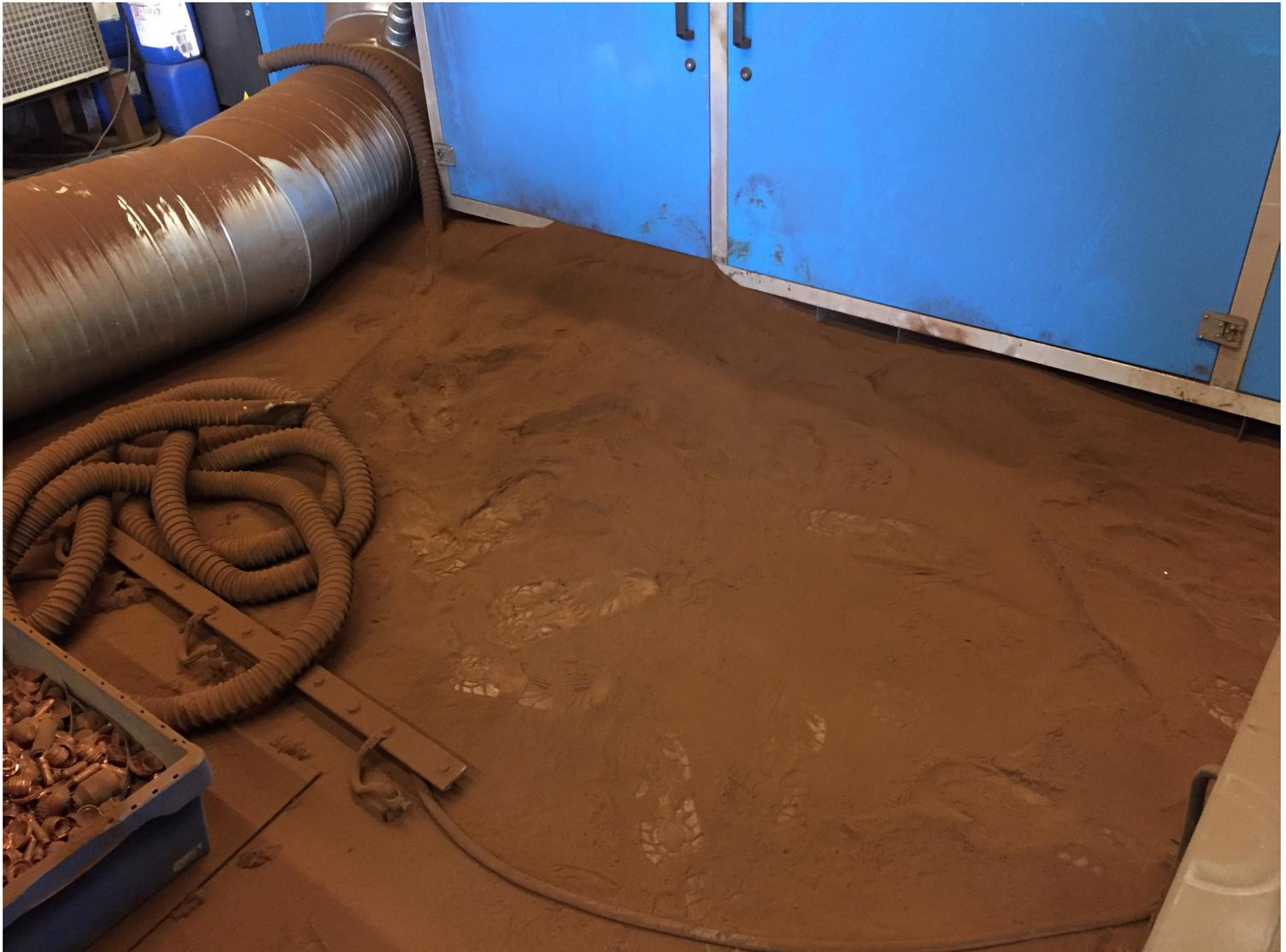
**Aufgrund der Gesundheitsgefährdung von Schweißrauch reicht es nicht, sich nur auf eine gute Absaugung und Luftfilterung zu verlassen. Auch die Staubentsorgung spielt eine große Rolle. Hierbei muss der Schweißer genauso vor Gefahrstoffen geschützt werden wie während des Schweißens.**
